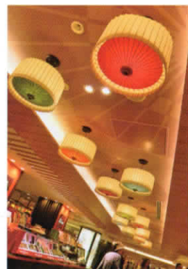
照明施工: JR京都駅
